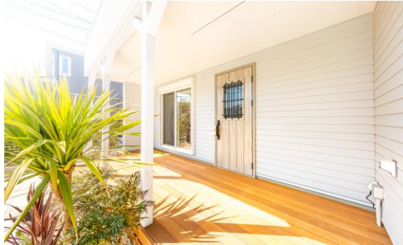
wood deck | カバードポーチがお出迎え
